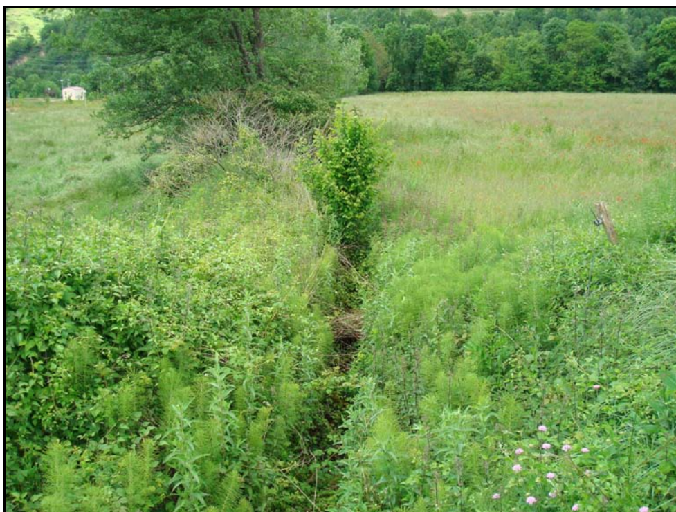
Foto núm. 7. Vista de la llera del rec aigua avall de l'obra de drenatge de la ctra. C-151, al seu pas per l'interior del sector "La Coromina del Bac".
