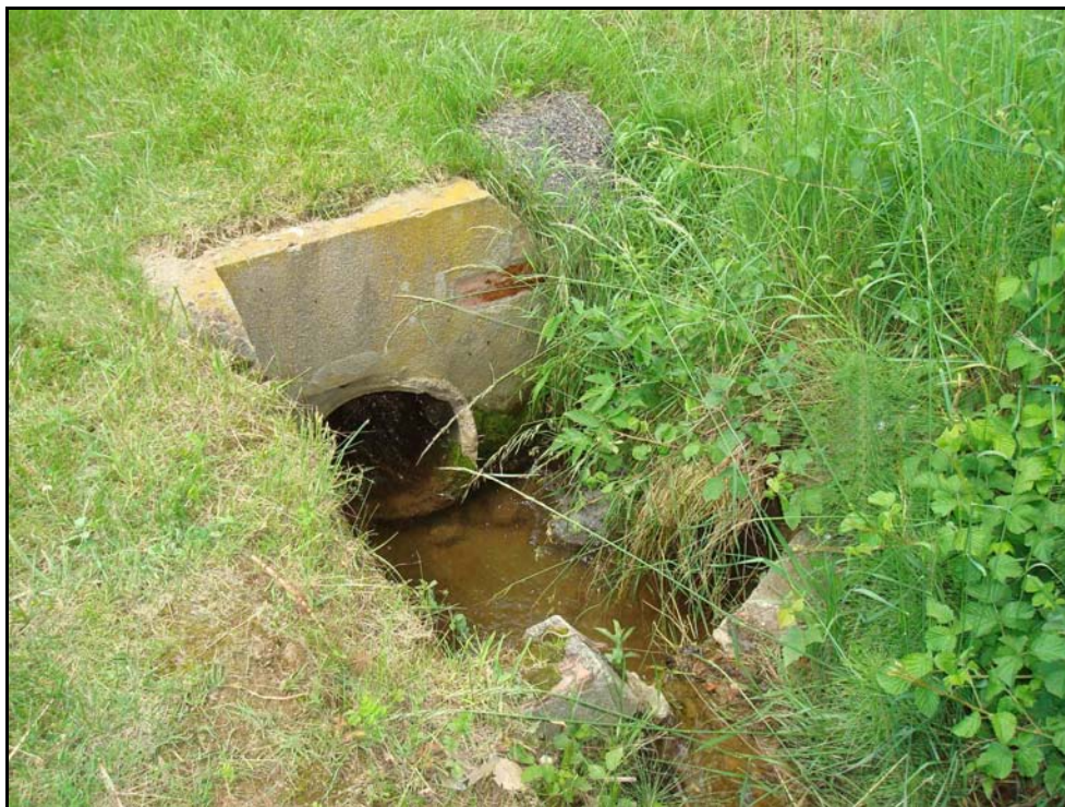
Foto núm. 6. Vista de l'obra de drenatge de la ctra. C-151.
