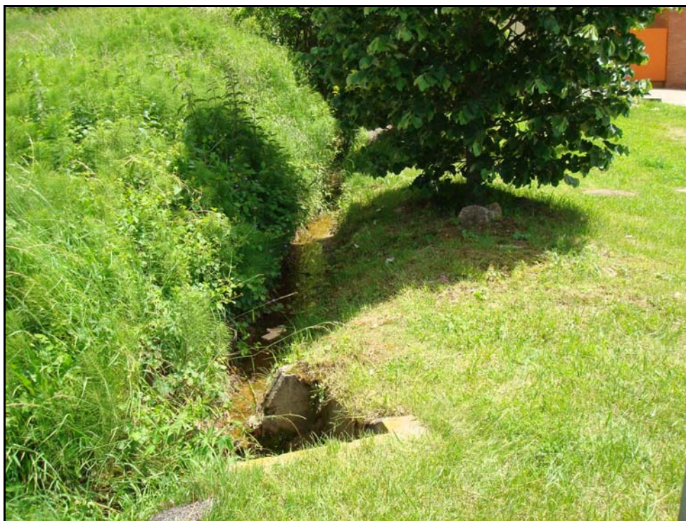
Foto núm. 5. Vista de la llera del rec aigua amunt de l'obra de drenatge de la ctra. C-151.
